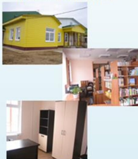
Строительство СКЦ в с. Дон
