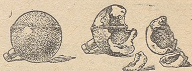
Рис. 114. Шучьгаланяе — чугуннöй бомба, көда тыртöма ваён; веськытланяе—сия жö бомбасы, көда поткötöма кыммөм ваён.
