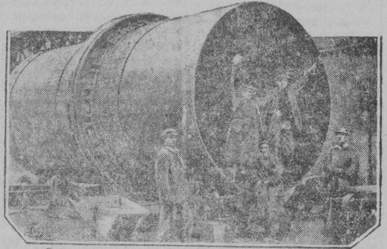
Северная судостроительная верфь в Ленинграде закончила постройкой двадцати-метровые печи для обжига цемента. Эти печи до сих пор в СССР не изготовлялись, а ввозились из-за границы. Постройка печей Сев. верфью кладет начало новому производству.
