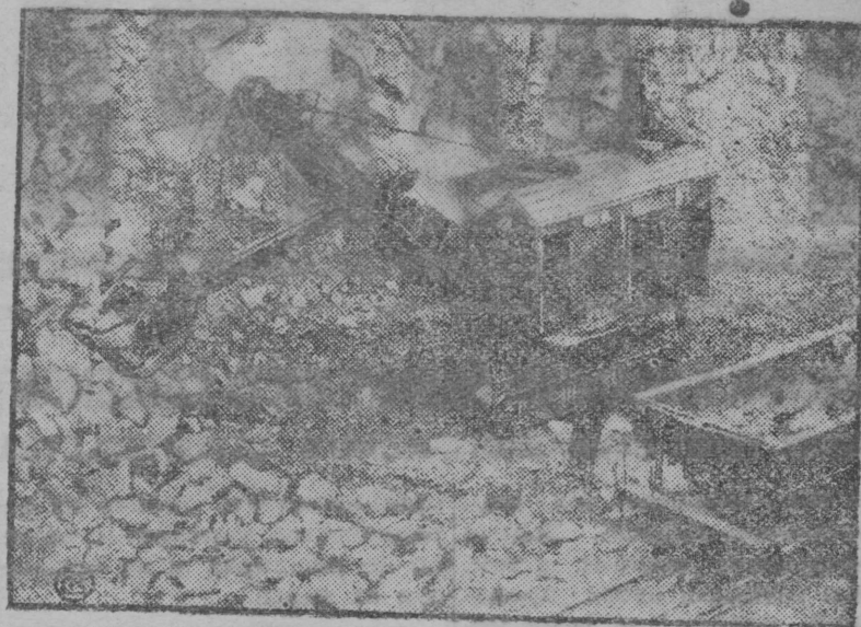
Скальные работы в котловане правого берега. Мощный паровой экскаватор выбирает ковшом раздробленный гранит и складывает его на железнодорожную платформу сирава.
