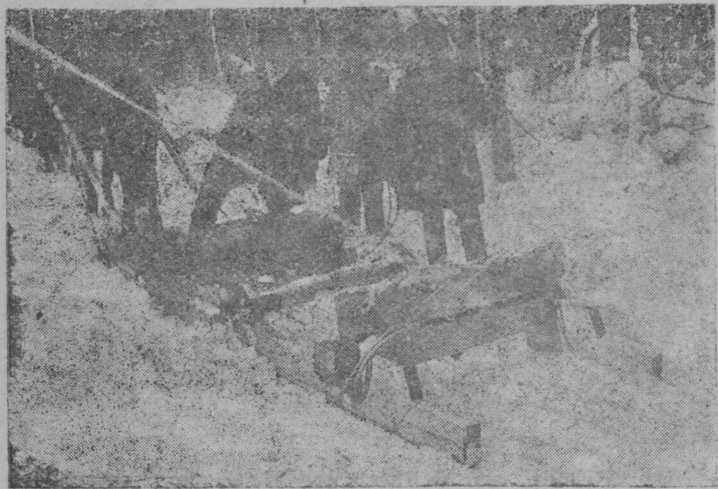
Посадки для возки леса по ледяной дороге.
