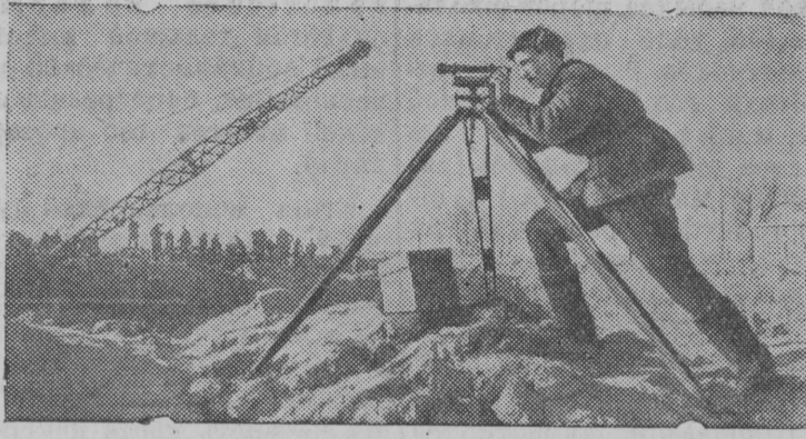
На снимке: На строительстве 10-го гидроузла Днепро-Бугского канала. Фото Д. Чернова.
