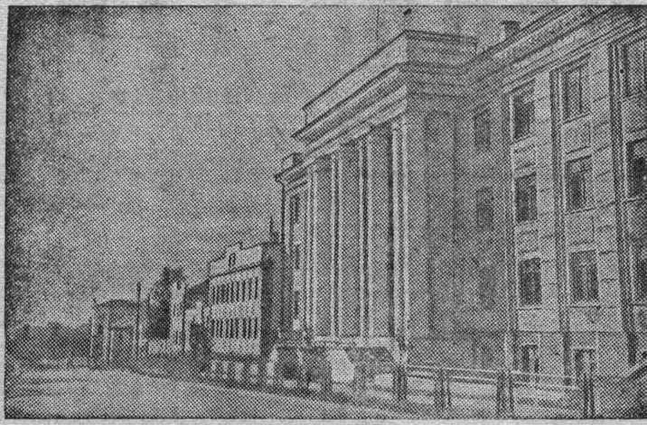
Новые дома на улице Кирова в гор. Сыктывкаре. (Коми АССР). Фото Н. Алексеева. Фото ТАСС.
