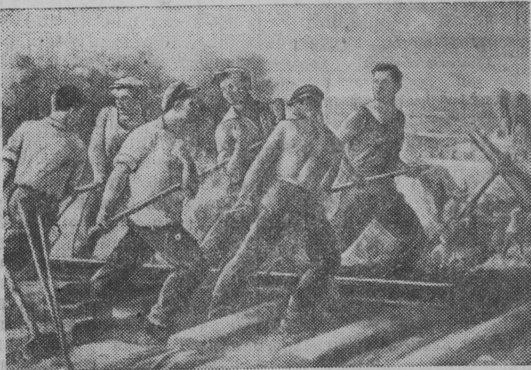
Снимок вылын: Комсомолецез железнодорожнэй магистраль Москва—Донбасс строительство вылын.
