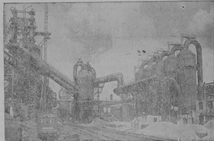
На снимке: На строительстве новой домны № 4 „Азовстали“ (Марнуполь).
