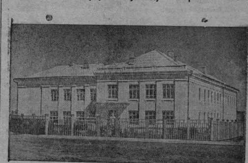
На снимке: Новое здание средней школы в Ишкар-Ола, построенное в 1939 г. методом скоростного строительства. Фото С. Чуришкова. Бюро-квше ТАСС.
