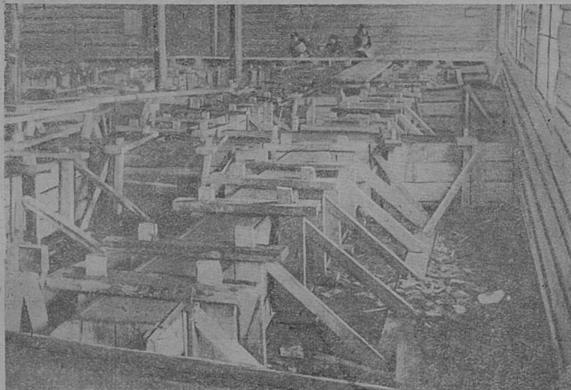
1 серп. Стрөителнөј сарәјын. Забетонитөм колонна- јас кујлөны сборнөј опалубкаын.
