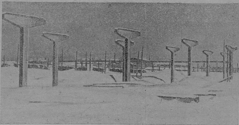
4-өд серп. Здањњојаслөн тöлын устанoвйтөм колоннајас.
