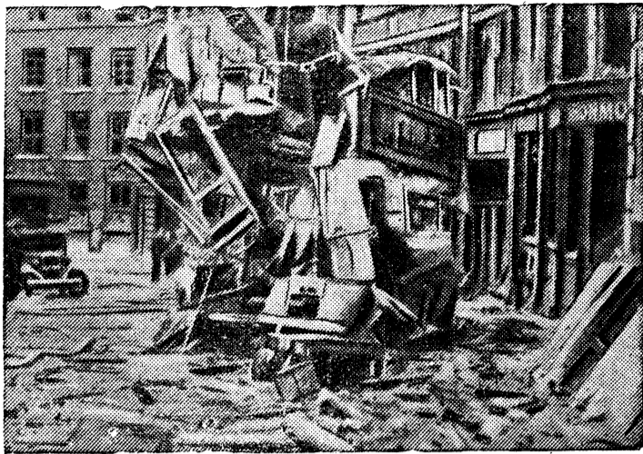
Разрушения на улицах Лондона в результате бомбардировки германской авиацией.
