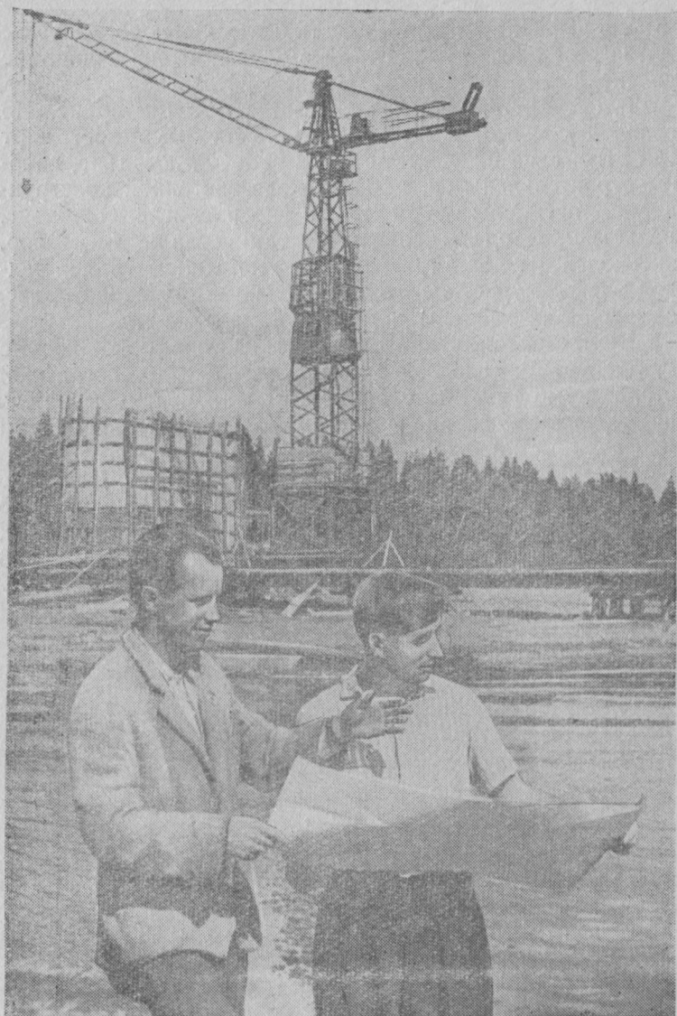
Инженеръяс (шуйгавывсянь) А. П. Шашков да И. М. Алексеенко Эжва во мѡн пос стрѡитанінын.
