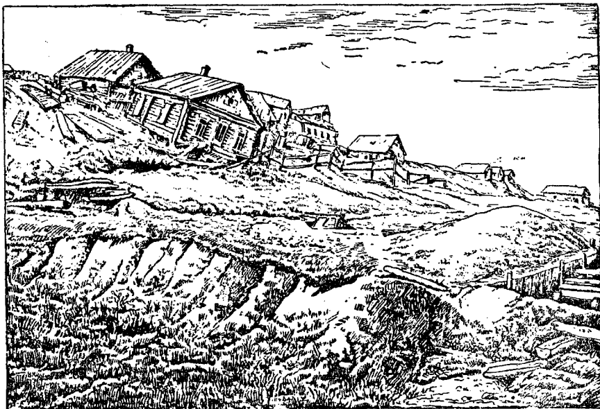
27-ѡд серпас. Волга берег вылын оползень (буждѡм).
