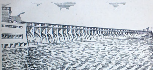
27 сўр. Днепрогэсын плотинаже.
