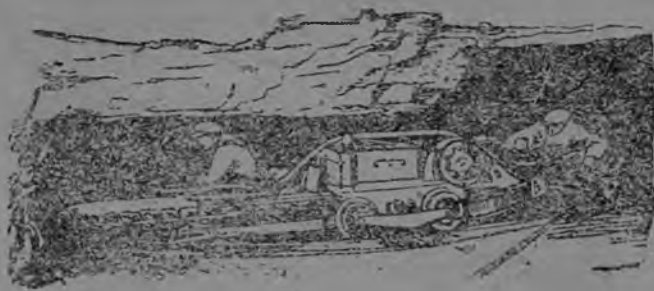
17-а сур. Пильылэсь машиналэн шахтаын ужалез.
